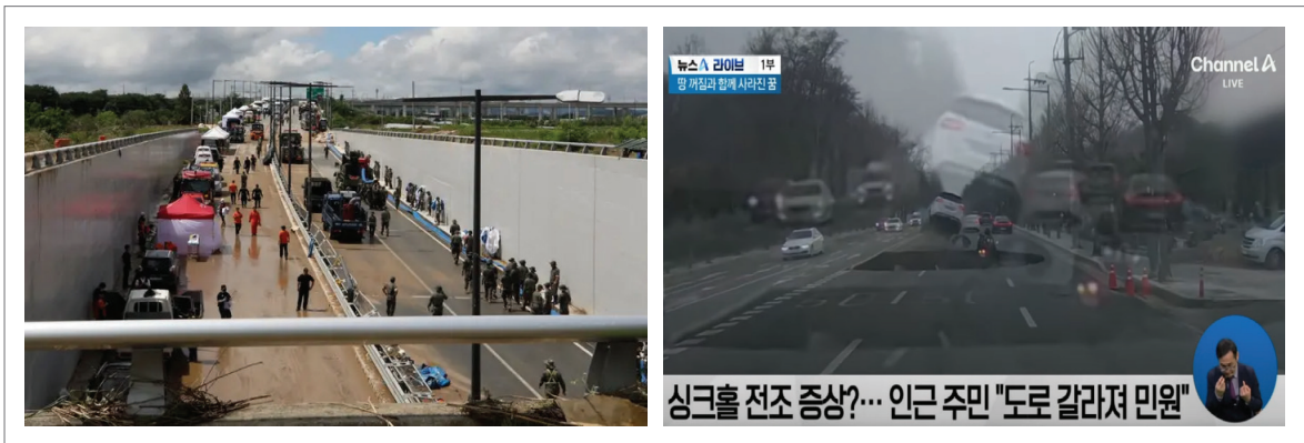
그림 1 배수구 막힘, 제방 붕괴 및 폭우 등으로 발생한 지하차도 침수 사례(좌), 싱크홀 사고 사례(우)
